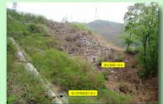
秋田県：山腹斜面の既設モルタル吹付面
