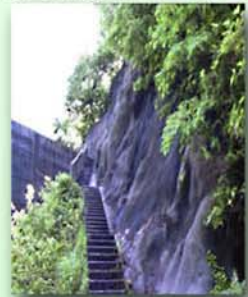
施工前(既設モルタル吹付面)
