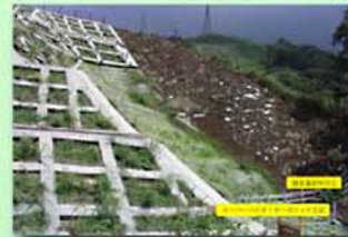
秋田県：山腹斜面の既設モルタル吹付面
