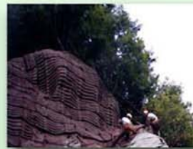
生育基盤材注入工
