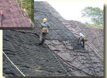
生育基盤材注入状況
